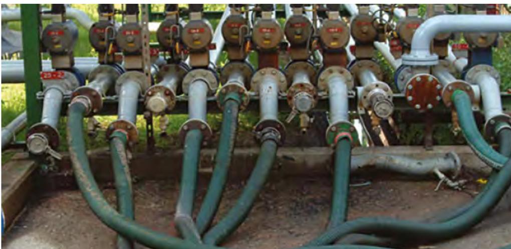
**SFO-03 Chemie-Folienwickelschlauch - Basis PTFE & V4A-Spirale - EN 13765**
